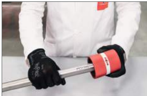
Sbavatura del tubo / Deburring the pipe
